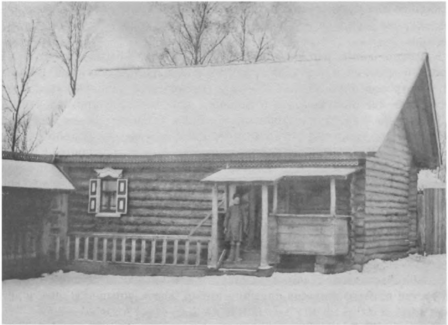
Дом зажиточного крестьянина. Вид со двора. Вдоль избы устроен проход на крыльцо. Начало XX в. НА ЧГИГН. Отд. VIII. Ед. хр. 74. № 32 Фото Н.В. Никольского
